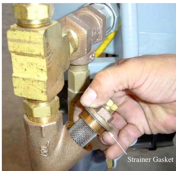
Fig. 3 Strainer Gasket
